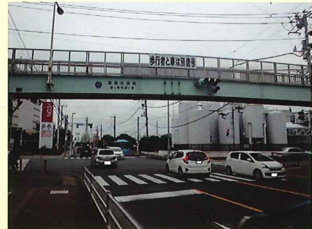
撤去される予定の歩道橋
