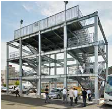
富士市鈴木本町にある津波避難タワー（H27建設）
