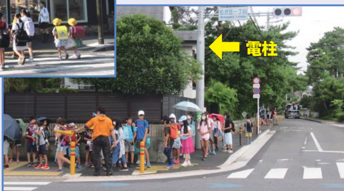
▼電柱を住居側に1m動かしました
