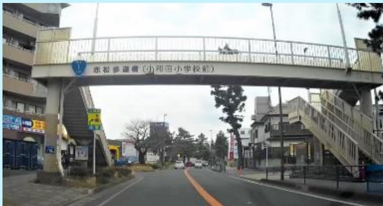
通学路にある国道1号線の歩道橋 (赤松歩道橋)
