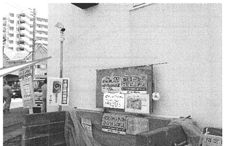
監視カメラ（ダミー）・ソーラー式センサーライト
