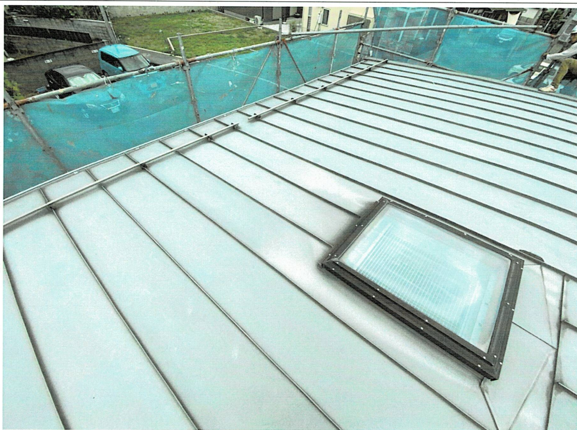
施工前(大屋根)
