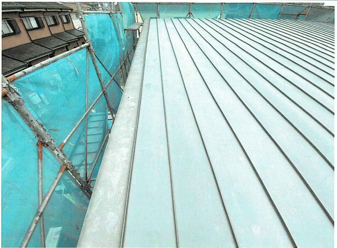
施工前(大屋根)
