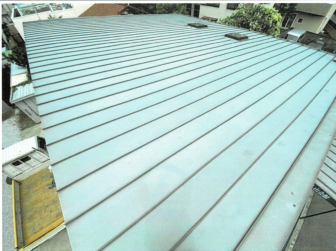
施工前(大屋根)
