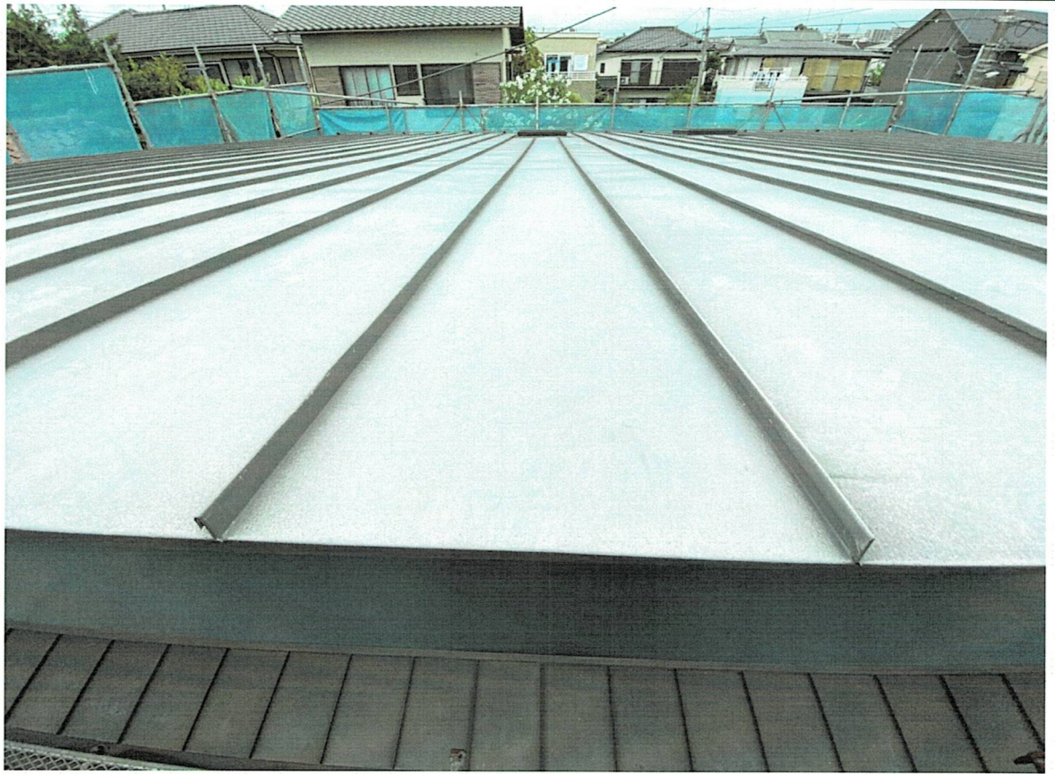
施工前(大屋根)
