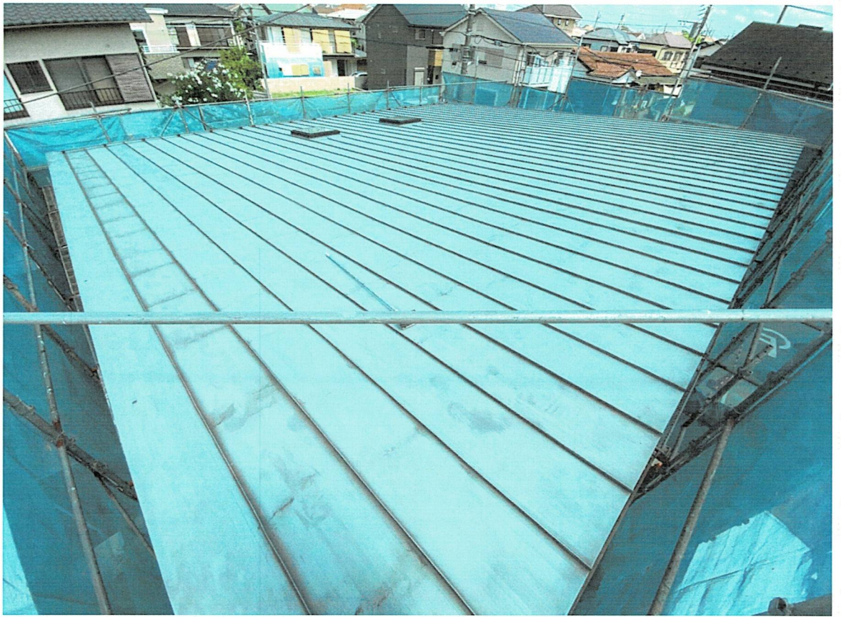
施工前(大屋根)
