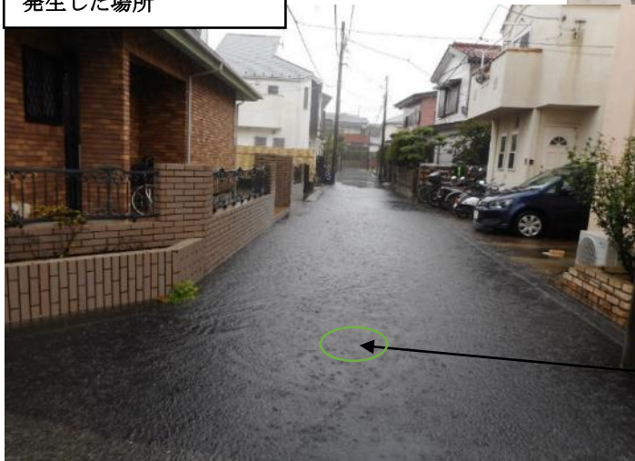
道路冠水が雨水管新設後発生した場所
