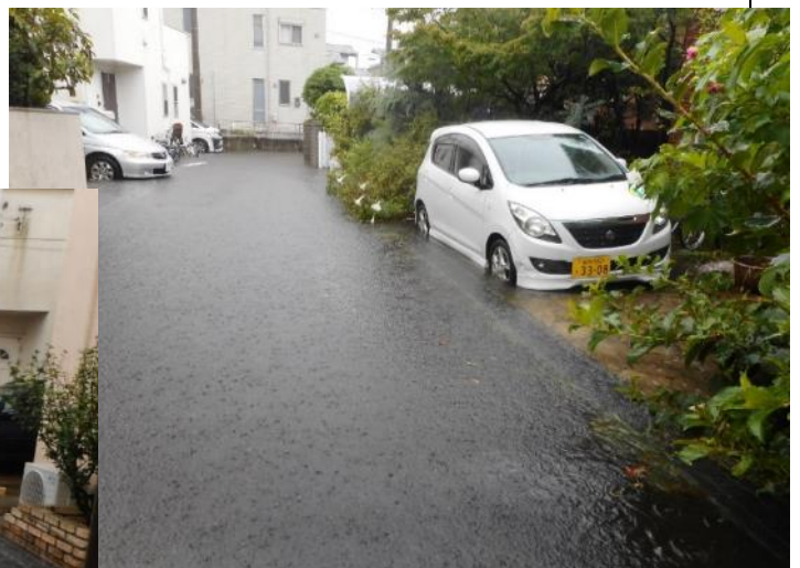
新設雨水管接続マンホール位置
