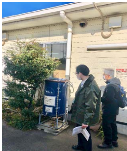
写真-1 雨水タンク設置状況
