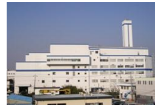
ごみ焼却処理施設
