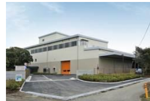
寒川広域リサイクルセンター
