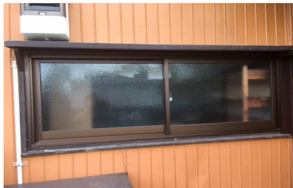
<流し場横の窓 リフォーム後>
