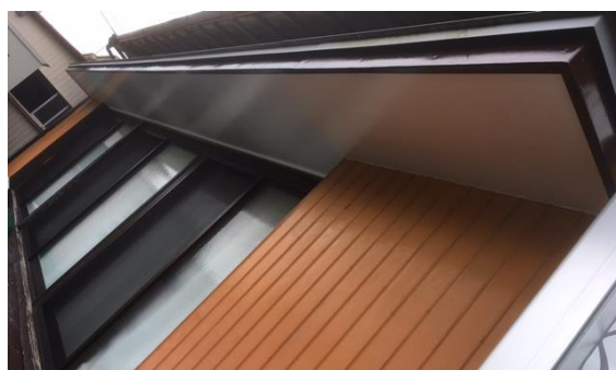
<南側窓上部の軒天 リフォーム後>
